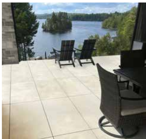
Balcons en béton
