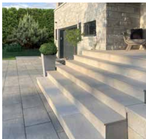
Escaliers en béton
