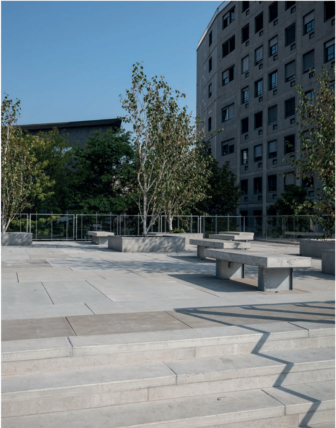
Politecnico di Milano – Promenade et passages piétons Milano, Italia Woodeck System – New Maxi NM
